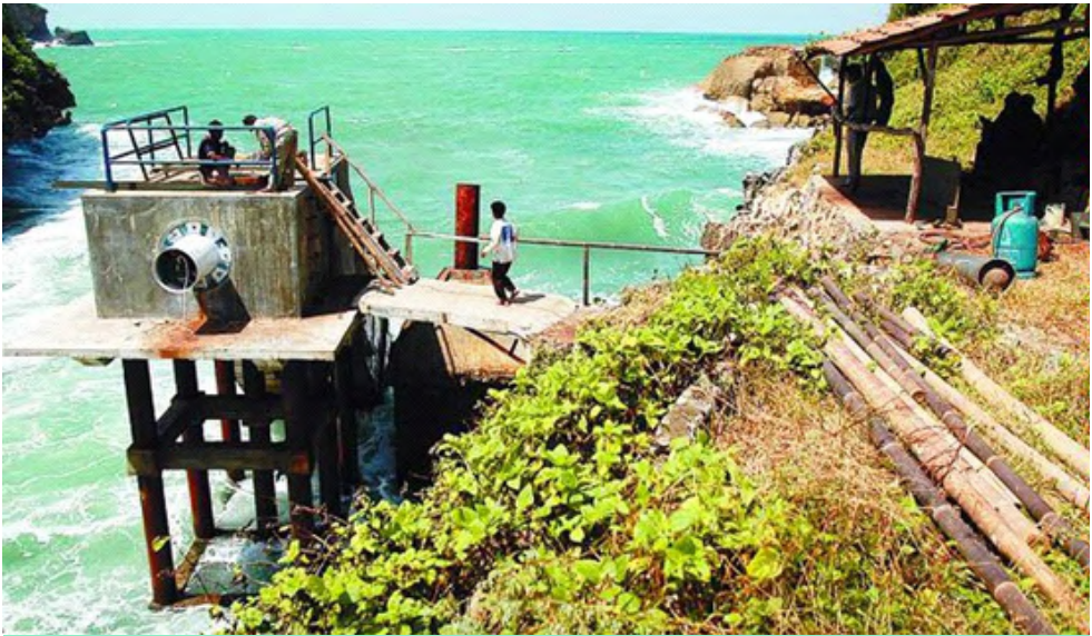
Sumber : Oscillating Water Column (OWC) 500 KW ombak pantai Pantai Parang Rucuk Tanjungsari Gunung Kidul Teknologi ini dikembangkan Balai Pengkajian Dinamika Pantai BPPT (Kompas) diakses dari http://alpensteel.com
